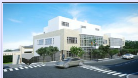
TRT-RS inicia construção de três novas sedes de Foro no interior do Estado
