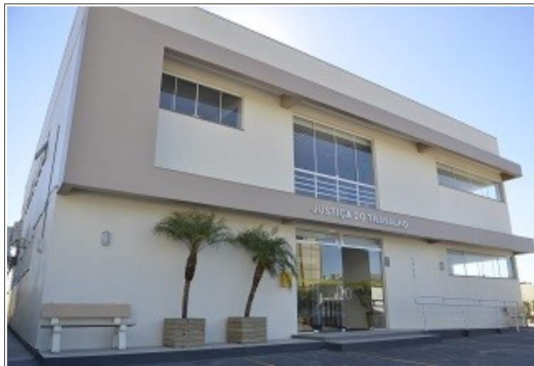
Novo prédio da VT de Torres
