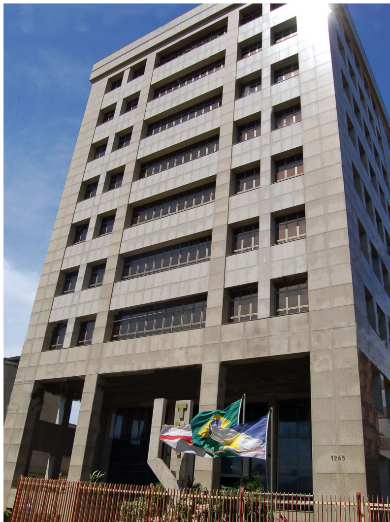
Prédio Sede do Tribunal Regional do Trabalho da 11ª Região.
