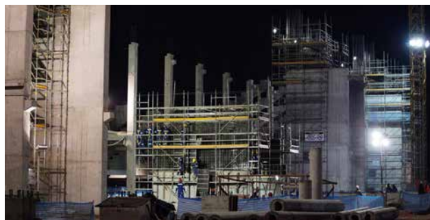
Obras no Estádio Arena Corinthians prosseguem durante a noite
