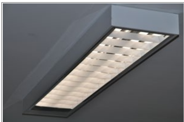
Luminárias possuem aletas anti-ofuscantes
