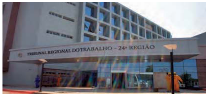
Novas instalações da sede do TRT da 24ª Região (em fase final de construção)
