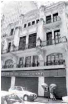
Prédio Rua Gen Camara 264
