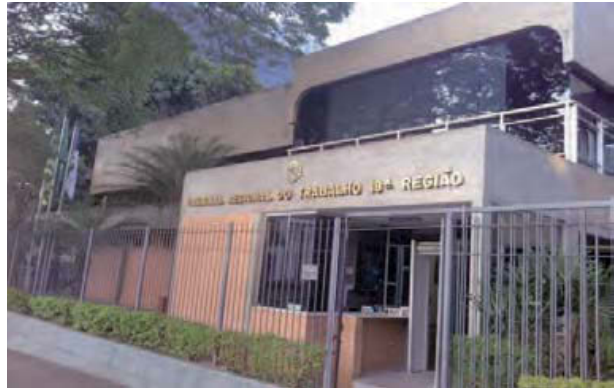
Edifício situado na Rua T-29, Setor Bueno, onde já funcionou a sede do TRT da 18ª Região. Atualmente este prédio abriga Varas do Trabalho, a AMATRA VXII, a AGATRA, a Secretaria de Tecnologia da Informação e a Coordenadoria de Cadastramento Processual.
