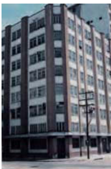
Prédio Rua Capitão Montanha 27
