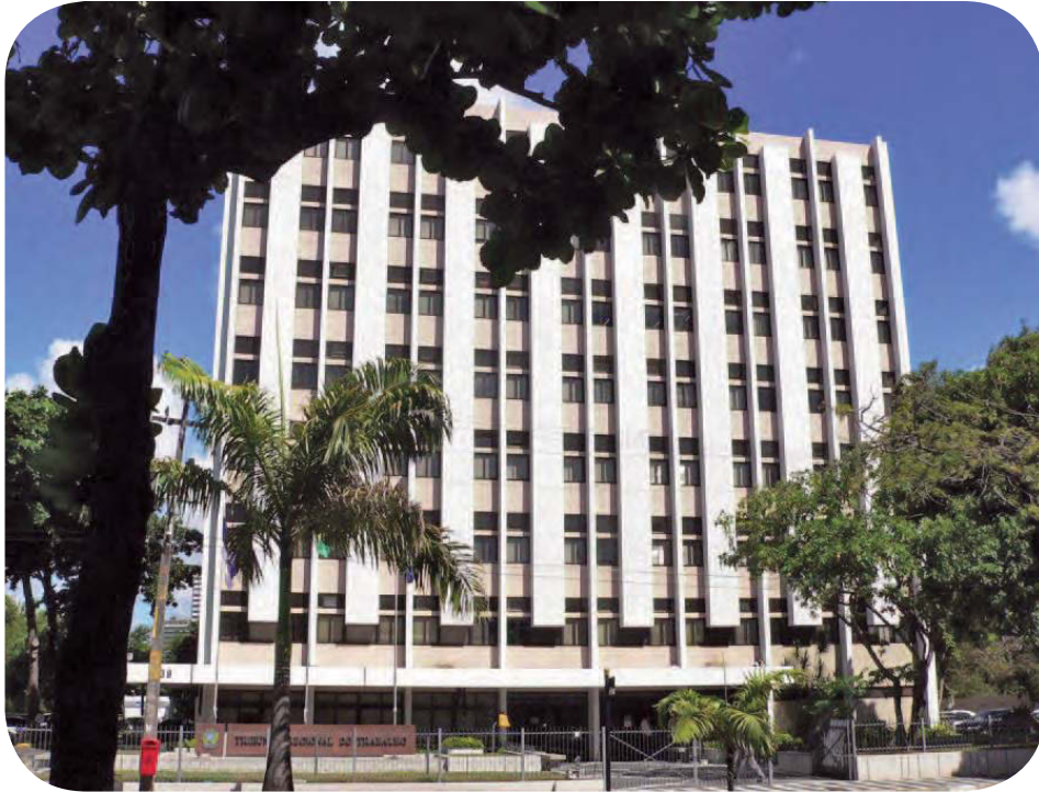
Sede do TRT6 – Cais do Apolo – Recife (PE)
