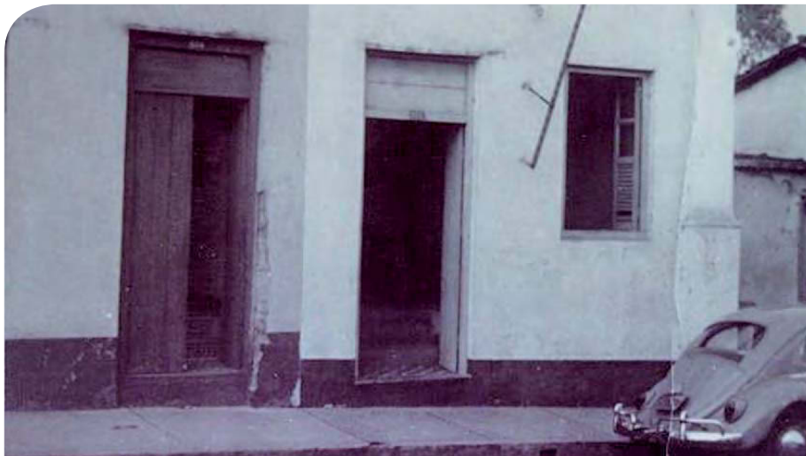
Antiga sede da Junta de Conciliação e Julgamento de Cuiabá, início da década de 1960
