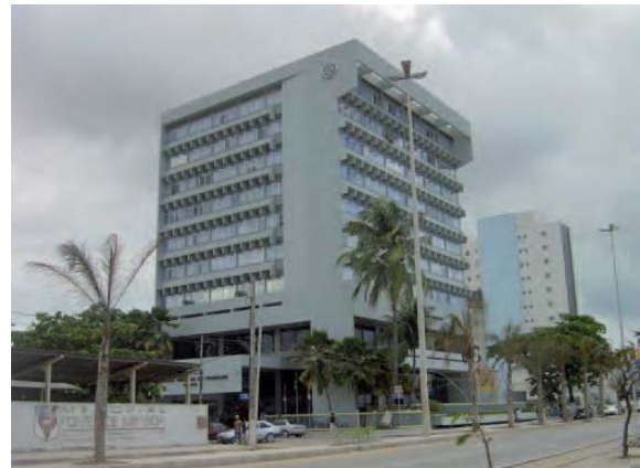
Fachada do atual prédio do TRT de Alagoas
