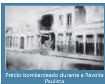
Prédio bombardeado durante a Revolta Paulista
