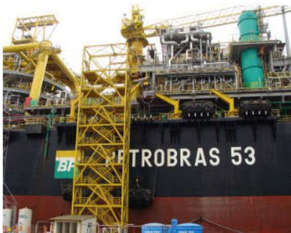
Construção de plataforma no estaleiro
