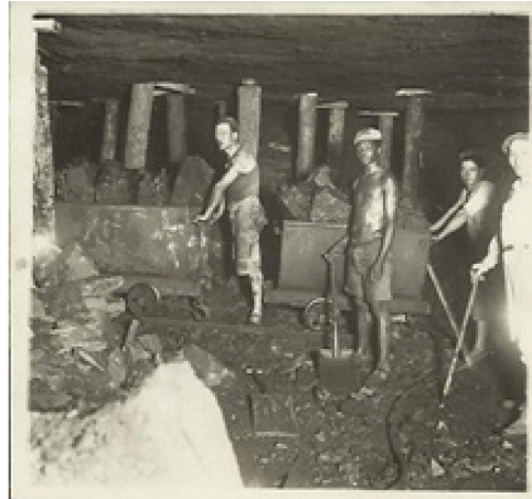
Figura 4 – Mineiros no subsolo das minas, com carregamento de carvão nos carros (s.d)
